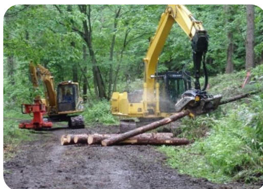
ハーベスターによる間伐作業
