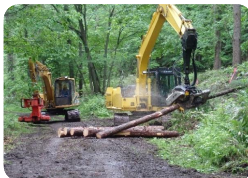
ハーベスターによる間伐作業
