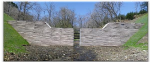
治山施設施工地（苫小牧市 樽前国有林）
