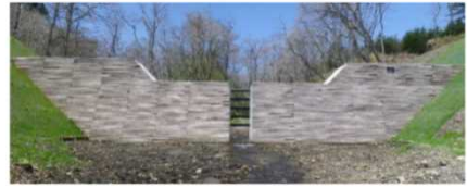
治山施設施工地
