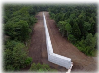
令和5年度完成 導流堤右岸部(西側)
