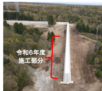
令和6年度完成 導流堤左岸部(東側)
