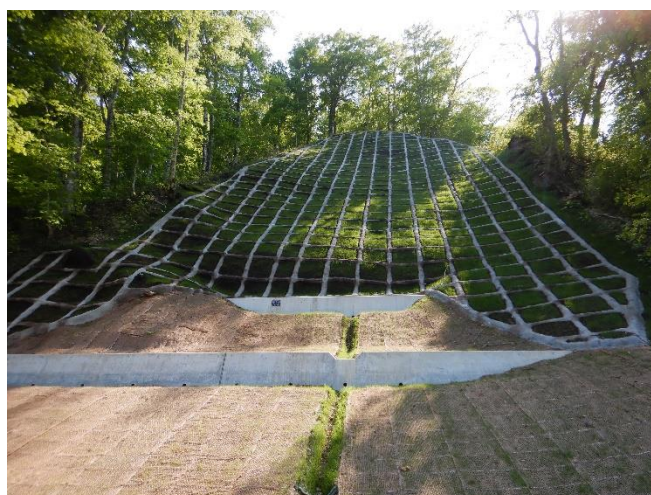
【木古内町：よびたらし地区治山工事】 (写真：簡易吹付のり砕工819㎡・コンクリート土留工2基)
