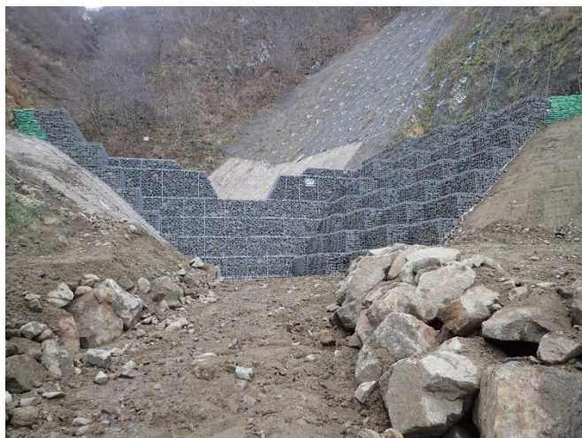
【奥尻町：幌内その3ほか2地区 災害関連緊急工事】 (写真：湯浜その2：鋼製谷止工1基)
