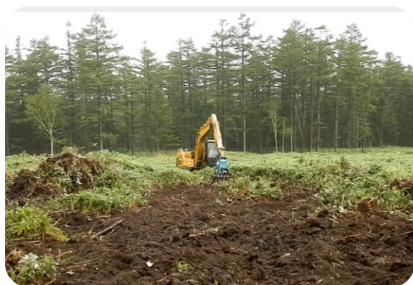
大型機械による地拵
