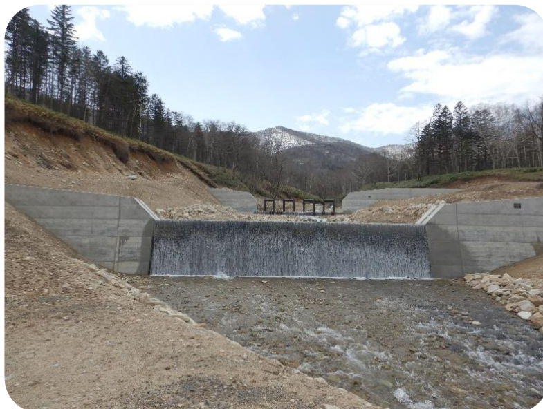
溪床の安定を図る治山工事
