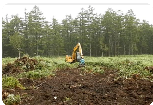
大型機械による地拵
