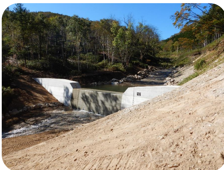
溪床の安定を図る治山工事
