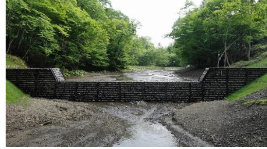
モイワ沢治山工事
