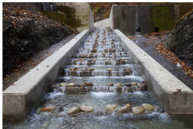
魚道を設置した仁世宇川支流の治山ダム
