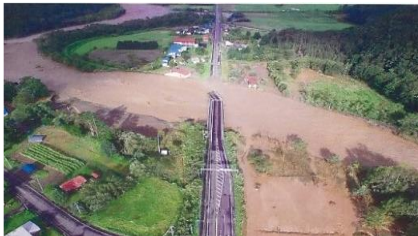
国道274号「千呂露橋」の被災状況（平成28年8月）
