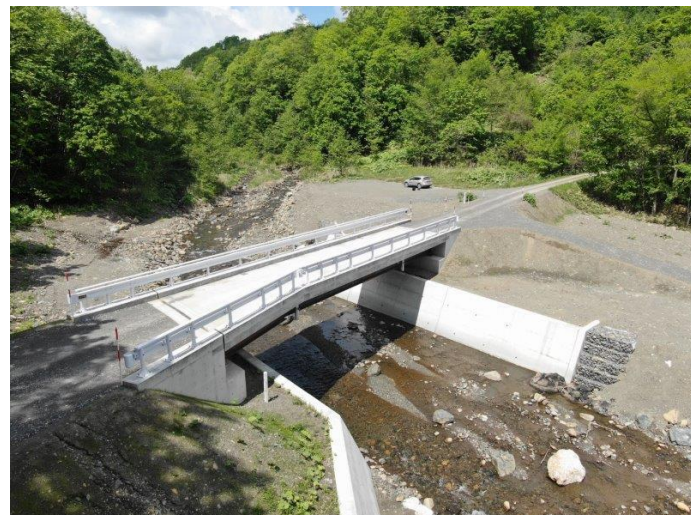
仁世宇併用林道・仁世宇3号橋 (令和4年度竣工)
