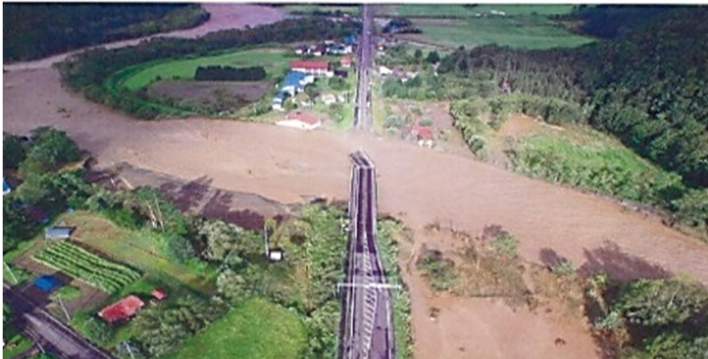
国道274号「千呂露橋」の被災状況（平成28年）
