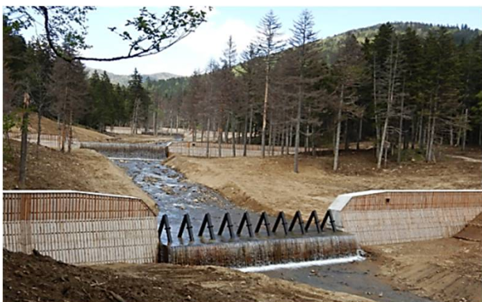
平成28年台風10号被災地の復旧治山施設
