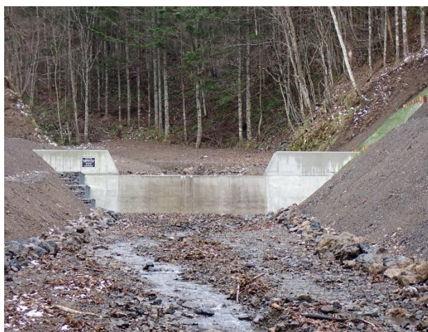
施工後の床固工(遠軽町)(令和7年11月)
