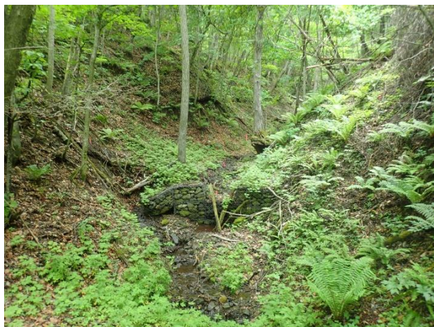
施工前の現地(遠軽町)(令和6年6月)
