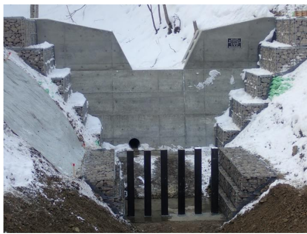
施工後の谷止・流木止工(遠軽町)(令和7年2月)
