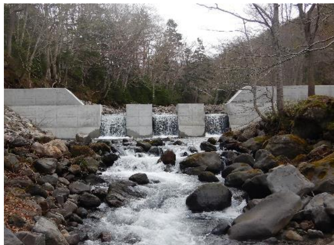
イワウベツ川治山工事(1回目)
