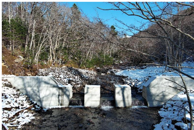
溪間工改良工事 (斜里町岩宇別地区イワウベツ川)
