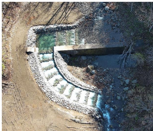
石組み魚道工 (斜里町ウトロ地区フンベ川)
