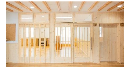
庁舎に木材を利用した森林技術・支援センター（令和6年2月完成）
