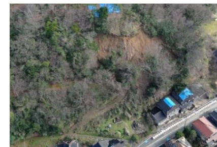
山地災害発生箇所でのドローンによる上空からの調査により、被害状況を安全かつ迅速に把握（写真は能登半島地震に伴う緊急派遣チームによる調査状況）
