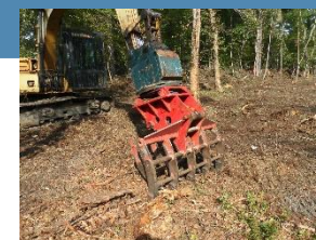
グラップルレーキによる地寄せ作業
