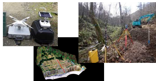
UAV写真測量等、ICTを施工現場に導入
