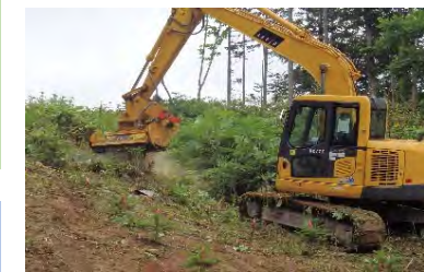
クラッシャーによる下刈り作業
