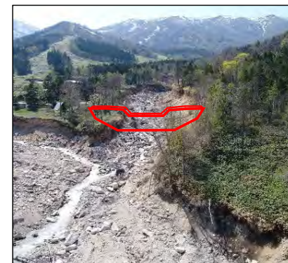
十勝西部署令和3年度施工箇所
