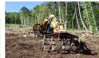
グラップルレーキによるササ類の根系切断・除去
