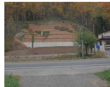
山腹荒廃地の復旧 (十勝東部森林管理署)
