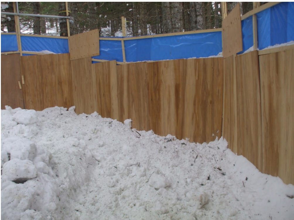
写真 15. 囲い部の内側全面に張った厚さ 6mm の木製合板.
