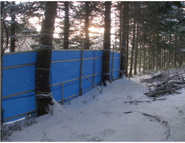
写真 2. 囲い部の外壁. 網とブルーシートの二重構造.
