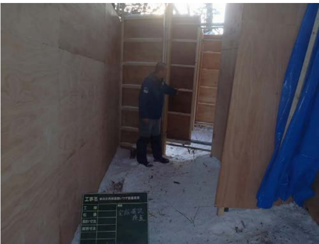
写真 4. 手前が障壁とブルーシートカーテン. 奥が仕切部屋の横スライド式扉
