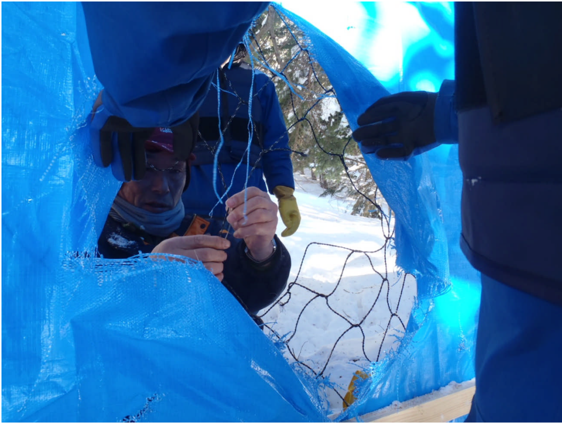
写真 13. エゾシカのたび重なる突進によって破られた囲い部の外壁.
