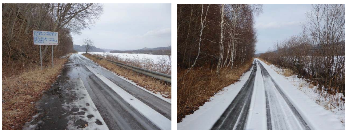
写真 7-1 ダム管理道の積雪状況（令和2年2月13日）
