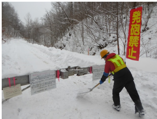
写真 6-7 ゲート前に雪を撒く作業
