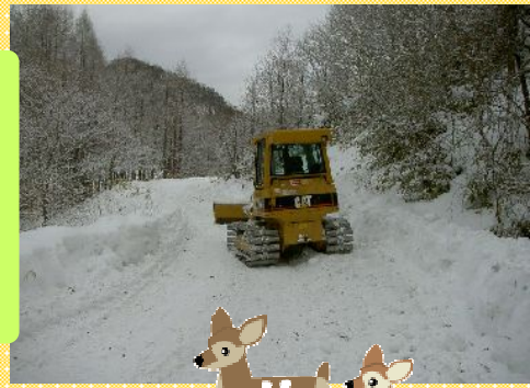
林道の除雪の様子
