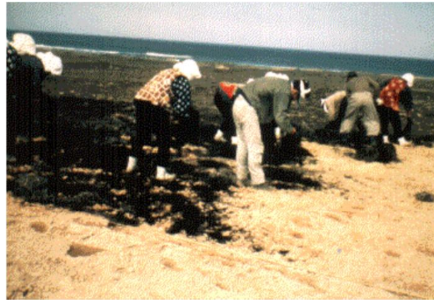
“えりも式緑化工法”（昭和32年） 草を根付かせるため雑海藻（ゴタ）をしきつめる住民と試行錯誤の末開発したもの
