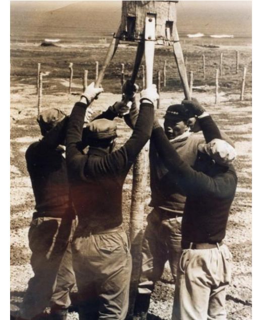
防風垣の杭打ちの様子
