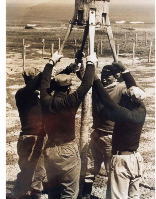
防風垣の杭打ちの様子
