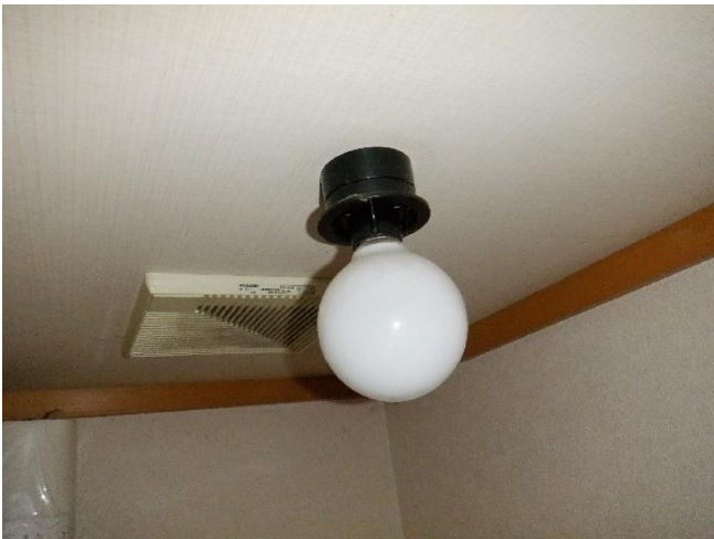
事務所トイレ灯
