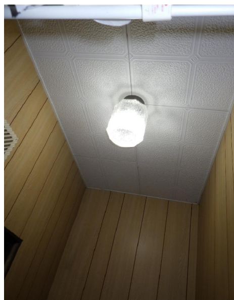
【車庫・休憩室トイレ】
