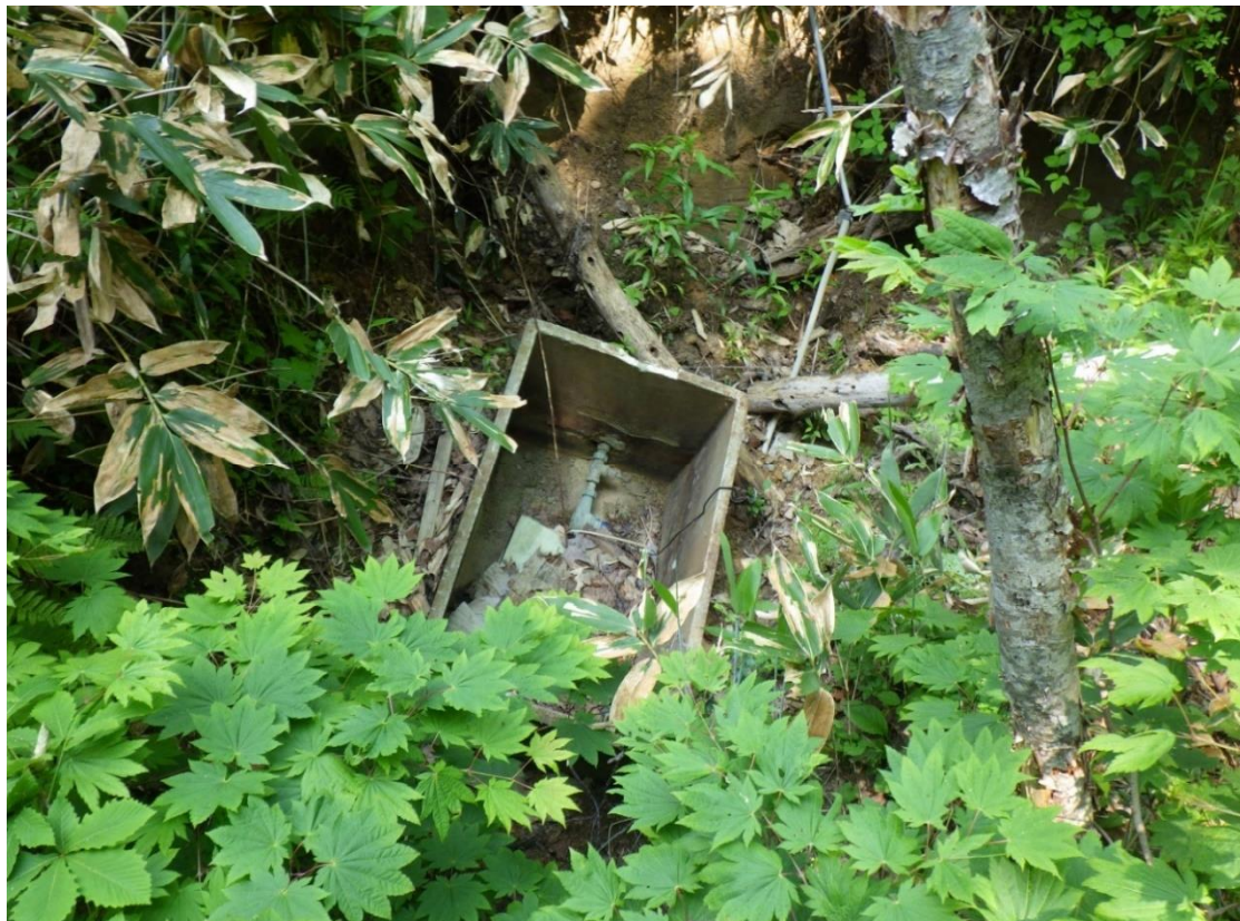
※給水口状況（近景）
