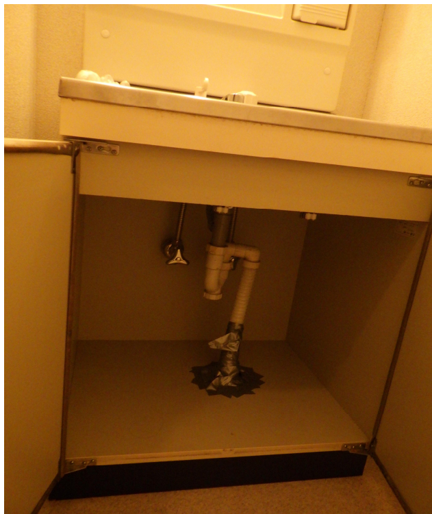
写真11： 脱衣所・洗面台（下部）
