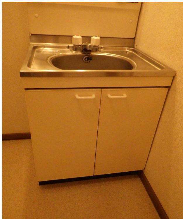
写真15： 脱衣所・洗面台（下部）
