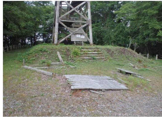
木製看板・階段（中に鉄板入り）
