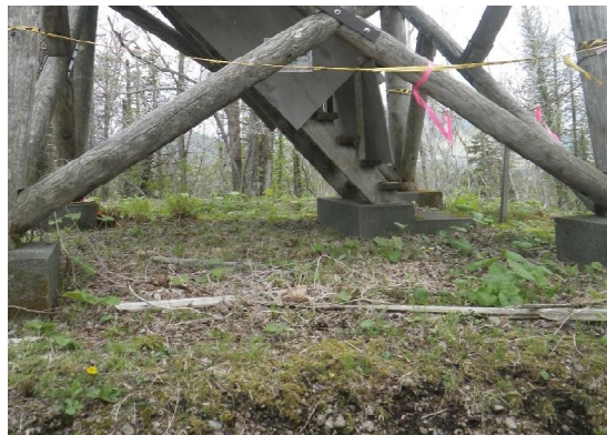
望楼基礎コンクリート
