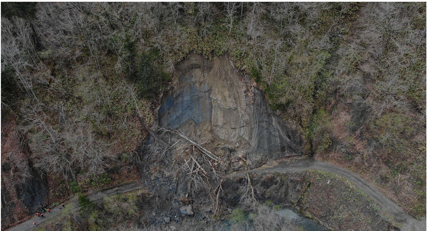
◇鹿島林道2.4km地点崩落箇所（上空正面）
