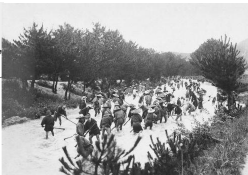
（川に堆積した土砂を鍬で揺すり、水の勢いで土砂を流す作業）
