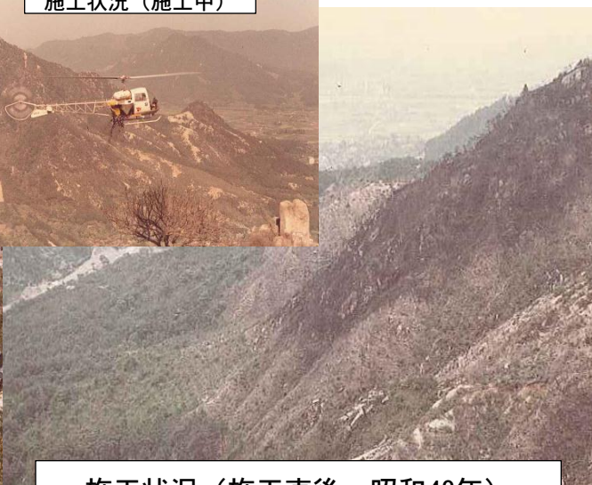
施工状況（施工直後 昭和43年）
