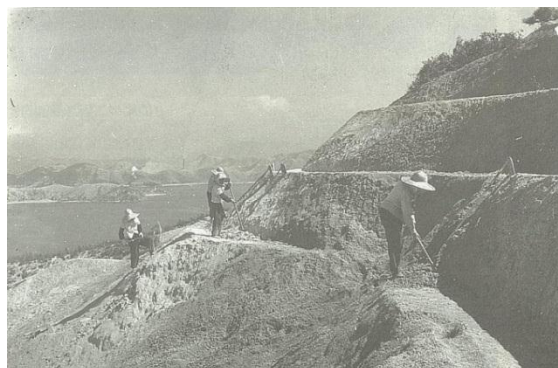
施工状況（昭和28年頃 階段切付）
