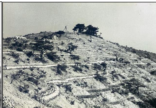
植生盤筋工による緑化（昭和35年）
