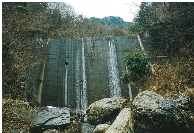
治山ダム現在の状況
