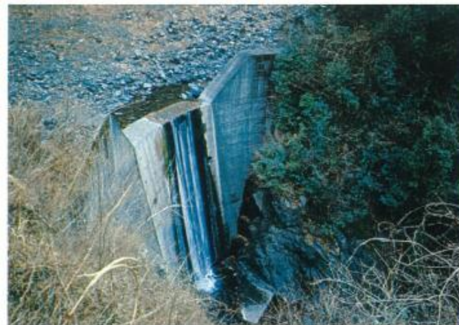
アーチダム施工時（昭和44年）
