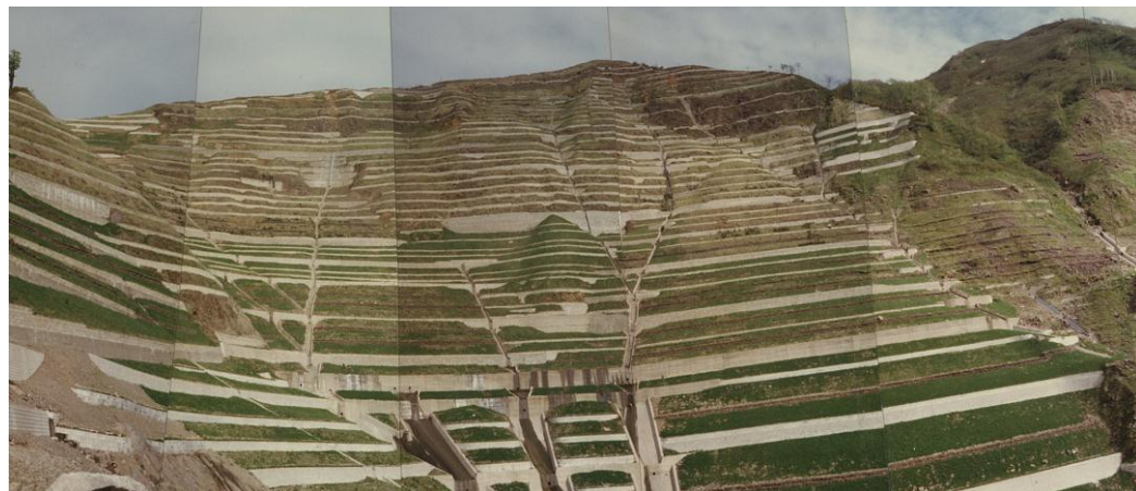
施工状況（昭和54年頃）
