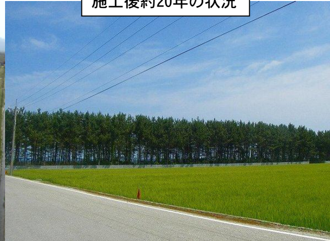
施工後約20年の状況
