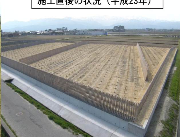
施工直後の状況（平成23年）
