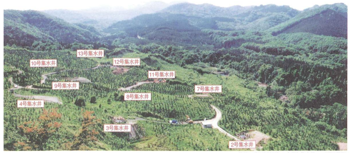
磐井川（岡山地区）の全景と集水井工の配置状況
