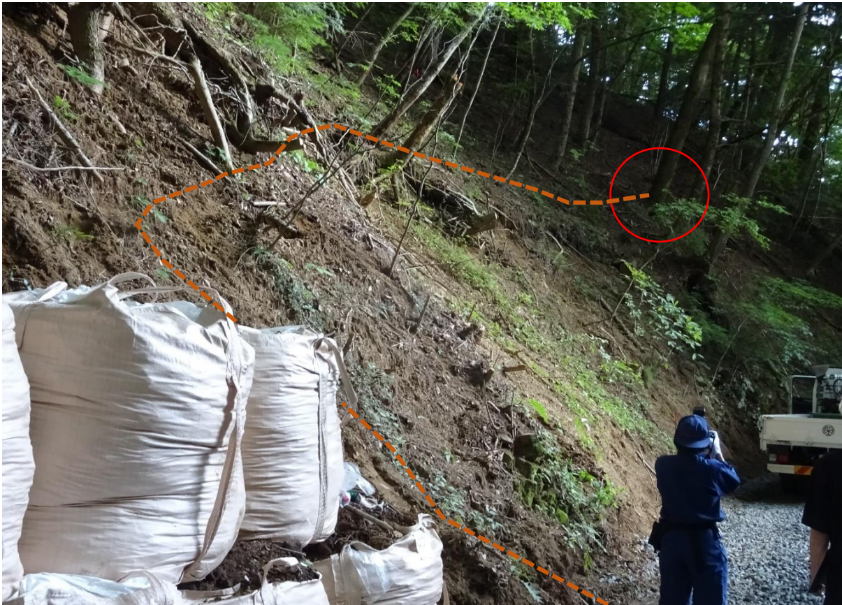
① 索道架設のための先柱となるモミを確認するため、林道の脇にある大型土のうの横を登り先柱となるモミの木へ横移動して向かい確認。
