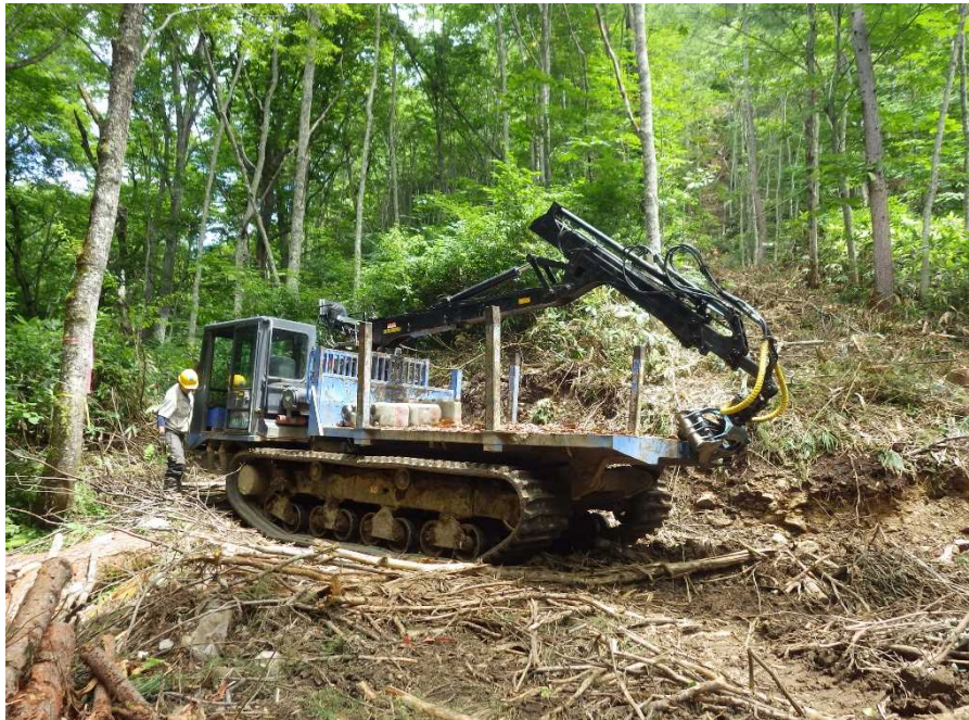
災害発生箇所 フォワーダによる 作業道への枝条敷き
