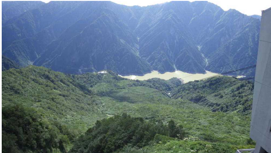
(写真 I - 1) 大観峰駅より全景
