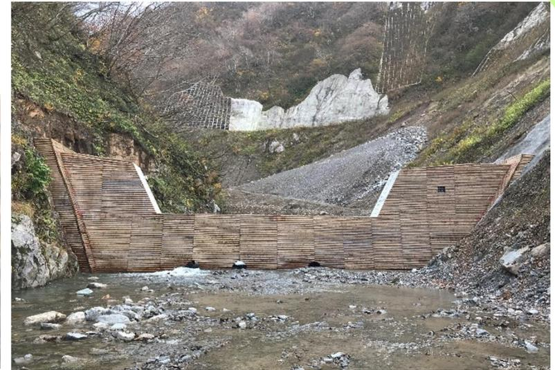
国産間伐材を使用した丸太残存型枠
