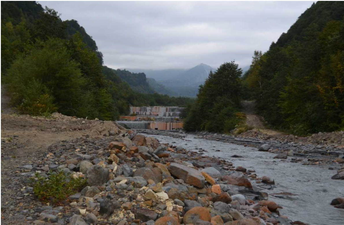
10月2日地上調査 濁沢川 除石実行箇所
