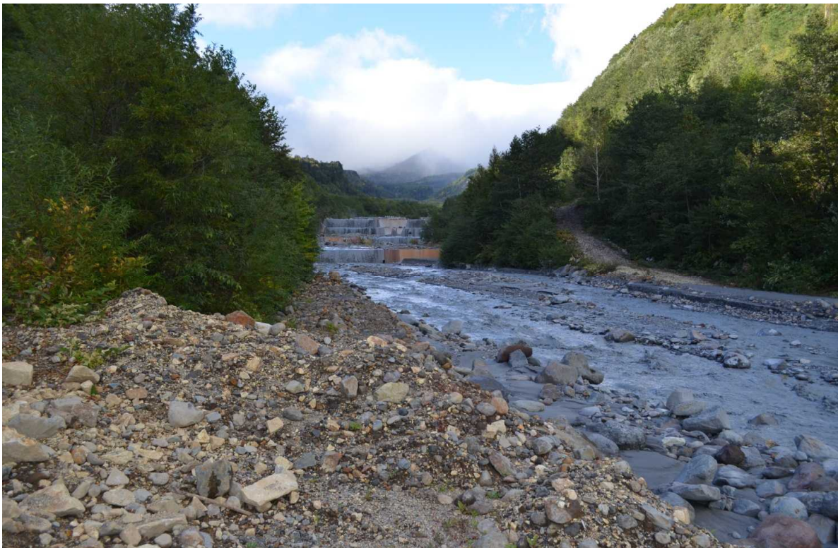
10月6日地上調査 濁沢川 除石実行箇所
