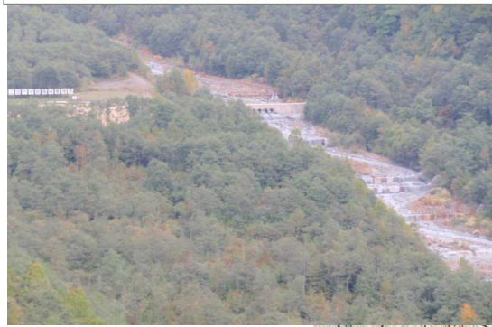
濁沢川下流部の治山ダム状況
