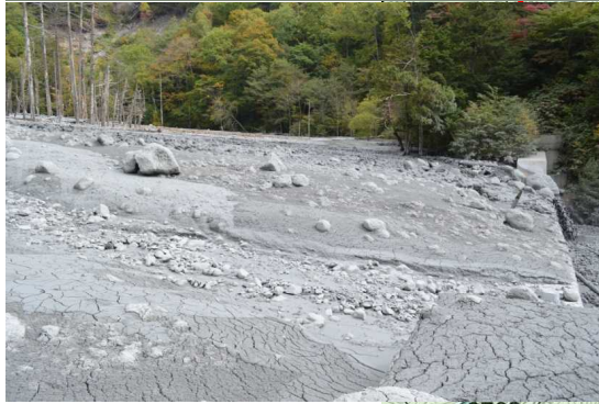
濁沢川最上流部の治山ダム状況
