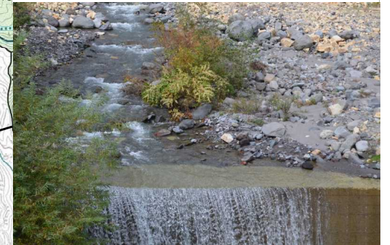
伝上川の治山ダム状況
