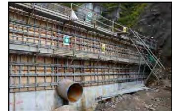
写真3：型枠設置状況
