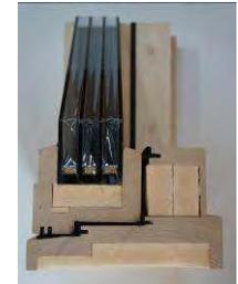
超断熱サッシ断面
