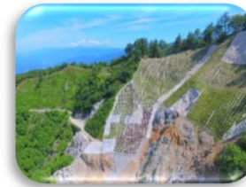
姥ナギ沢復旧治山工事
